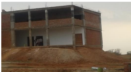
Schulhaus Rohbau anfangs 2015
