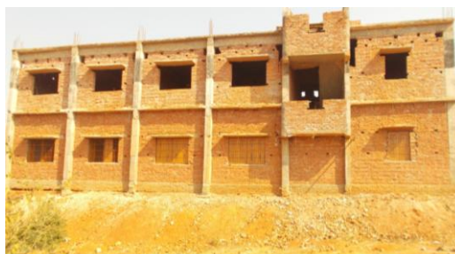
Schulhaus mit Innenausbau 1. Stock April 2015
